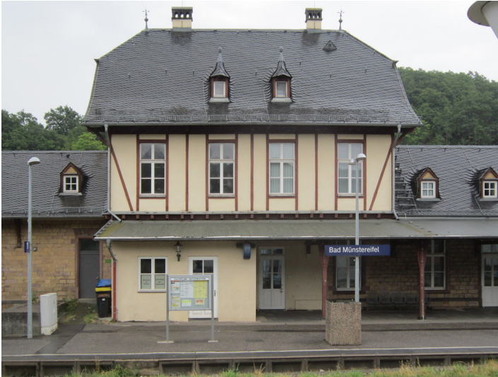
Bahnhof Bad Münstereifel, Empfangsgebäude (2015) Fotograf/Urheber: Claus Weber
