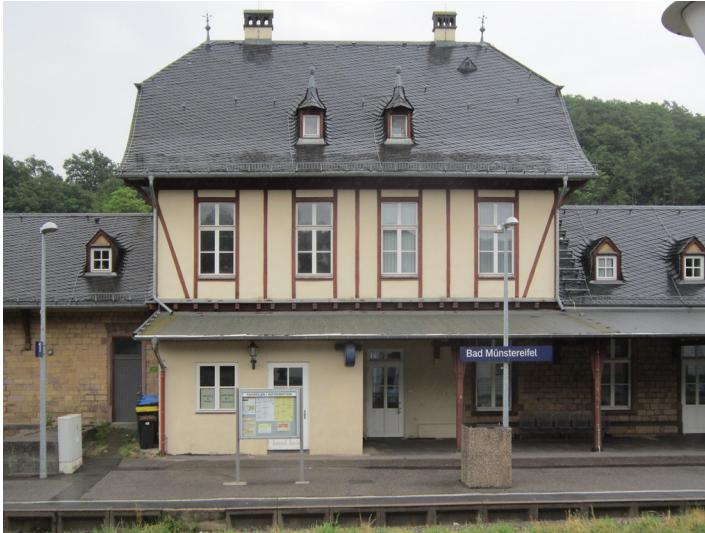
Bahnhof Bad Münstereifel, Empfangsgebäude (2015) Fotograf/Urheber: Claus Weber
