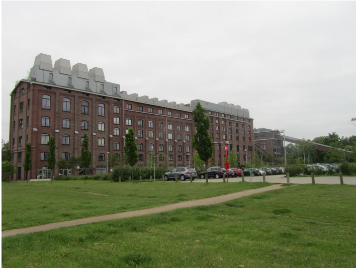
Das aus Backstein und Stahlfachwerk errichtete Pressen- und Trockenhaus der Brikettfabrik Carl in Frechen wird heute zu Wohnzwecken genutzt (2014). Fotograf/Urheber: Nicole Schmitz
