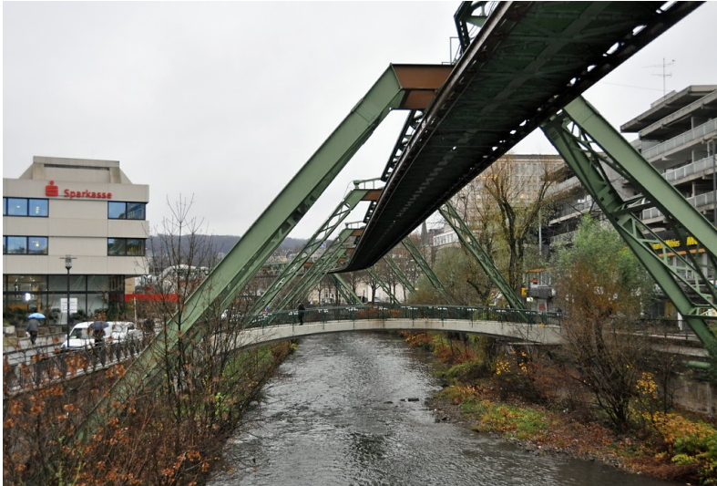
Die Trasse der hier parallel zum Fluss Wupper verlaufenden Wuppertaler Schwebebahn im Bereich der Straße Islandufer (2014). Fotograf/Urheber: Franz-Josef Knöchel
