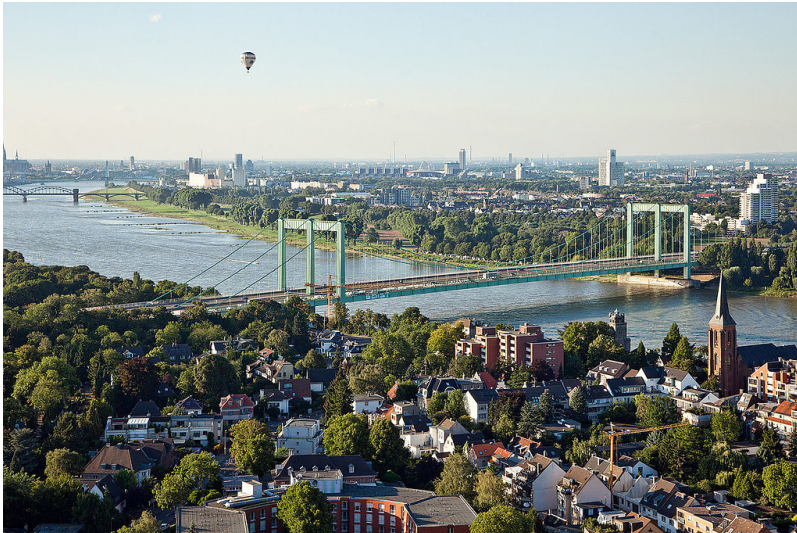
Luftbild mit der Rodenkirchener Rheinbrücke im Süden von Köln (2010). Im Vordergrund ist der Kölner Stadtteil Rodenkirchen und im Hintergrund der Stadtteil Deutz zu sehen.
