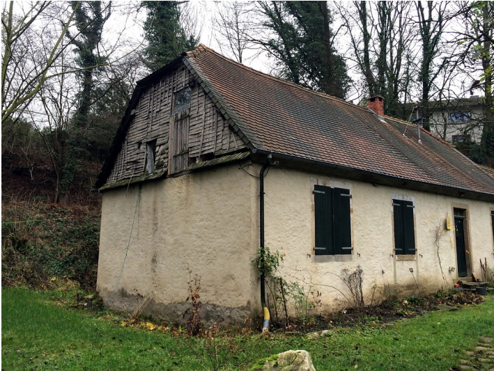
Seitenansicht des Zweifamilien-Hüttenmeister-Hauses der ehemaligen Eisenhütte Abenteuer (2015) Fotograf/Urheber: Nicole Etzkorn
