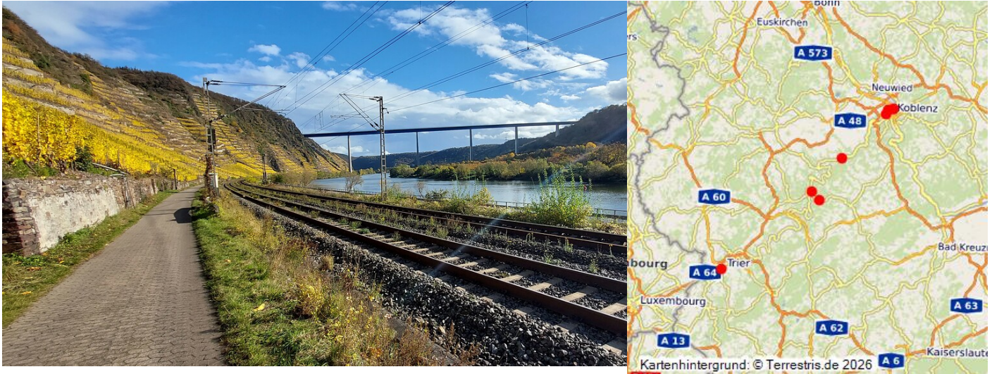
Die über das Moseltal führende Autobahnbrücke der A 61 bei Winningen / Dieblich, Ansicht von Koblenz-Gondorf aus, rechts im Bild Gleise der Moselstrecke der Bahn (2021). Fotograf/Urheber: Franz-Josef Knöchel
