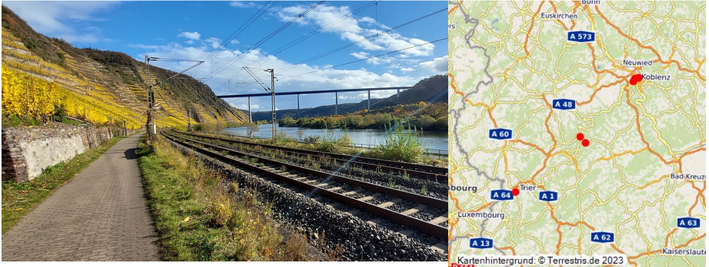
Die über das Moseltal führende Autobahnbrücke der A 61 bei Winningen / Dieblach, Ansicht von Koblenz-Gondorf aus, rechts im Bild Gleise der Moselstrecke der Bahn (2021). Fotograf/Urheber: Franz-Josef Knöchel
