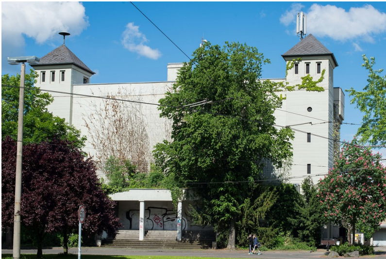
Hochbunker in Dottendorf, Quiriniusplatz (2013) Fotograf/Urheber: Caecilius Mauß
