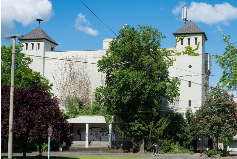
Hochbunker in Dottendorf, Quiriniusplatz (2013) Fotograf/Urheber: Caecilius Mauß
