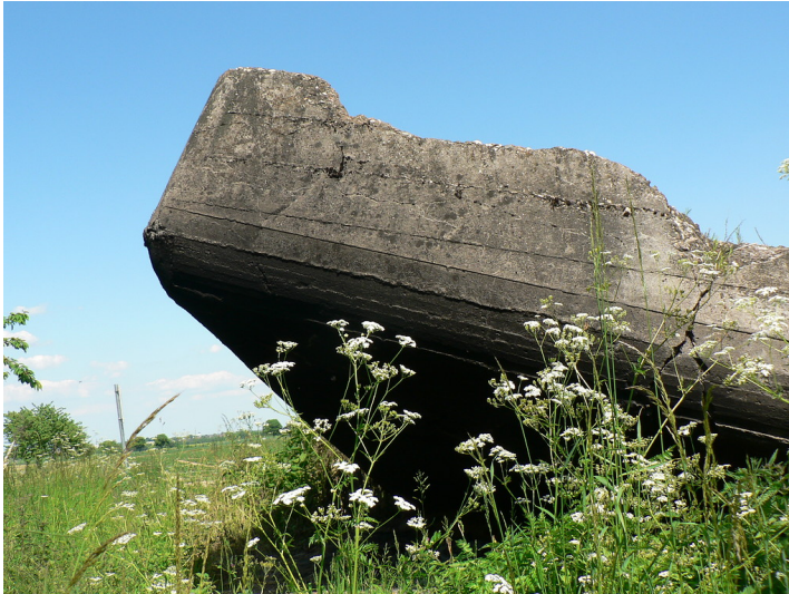
Decke des gesprengten Bunkers in Zülpich-Langendorf (2013) Fotograf/Urheber: Ingrid Mentzel
