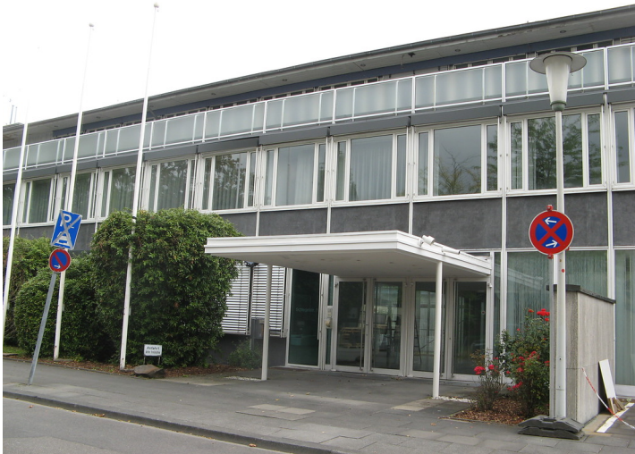
Die Eingangsseite der ehemaligen Landesvertretung Bayern von der Bonner Schlegelstraße aus gesehen (2008) Fotograf/Urheber: Angelika Schyma
