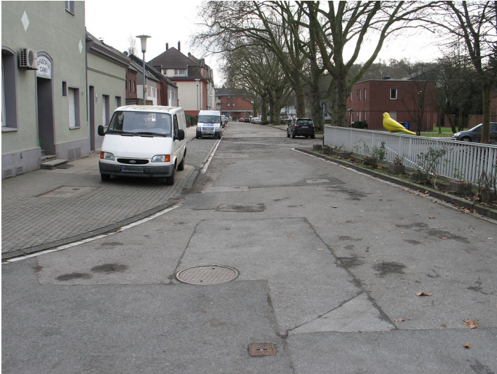
Straße Meybuschhof, ursprüngliche Trasse der Straßenbahn von Katernberg zur Herrmannstraße (2011) Fotograf/Urheber: Claus Weber
