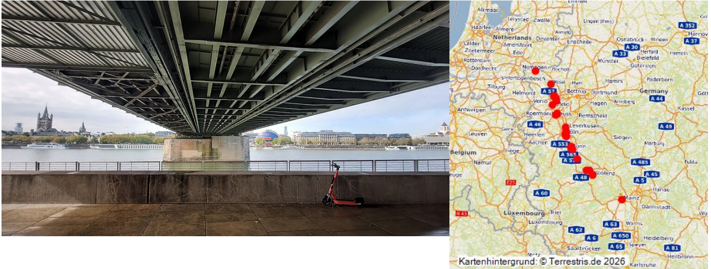
Blick von der Deutzer Rheinseite auf die Unterkonstruktion (Unterzug) der Hohenzollernbrücke (2022). Fotograf/Urheber: Franz-Josef Knöchel
