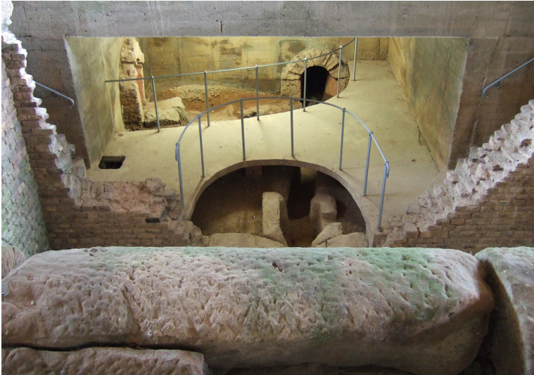
Brunnenstube Klausbrunnen in Mechernich-Kallmuth (2013) Fotograf/Urheber: Hoppe, Wiebke
