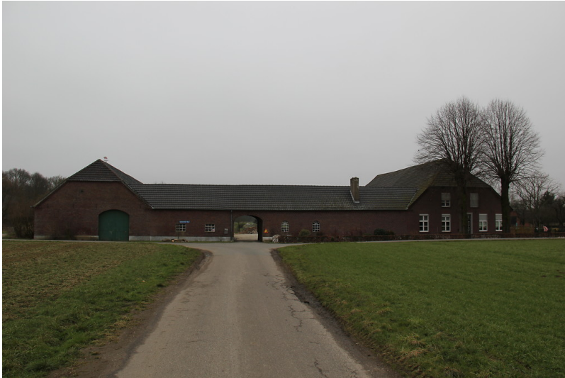
Westansicht des Rühlenhofs in Uedem-Uedemerfeld mit dem dahin führenden Weg (2013). Fotograf/Urheber: Peter Burggraaff
