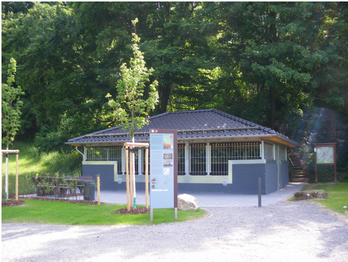
Der frisch renovierte Schutzbau der Brunnenstube "Klausbrunnen" der römischen Eifel-Wasserleitung in Mechnich-Kallmuth (2013). Fotograf/Urheber: Schumacher, Gabriele
