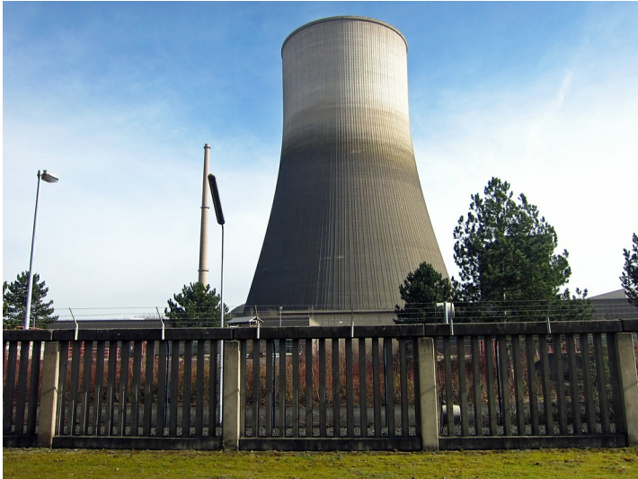
Der 162 Meter hohe Kühlturm des 1986-1988 betriebenen Kernkraftwerks Mülheim-Kärlich im Neuwieder Becken am Rhein, Ansicht aus westlicher Richtung (2015) Fotograf/Urheber: Levin Montermann
