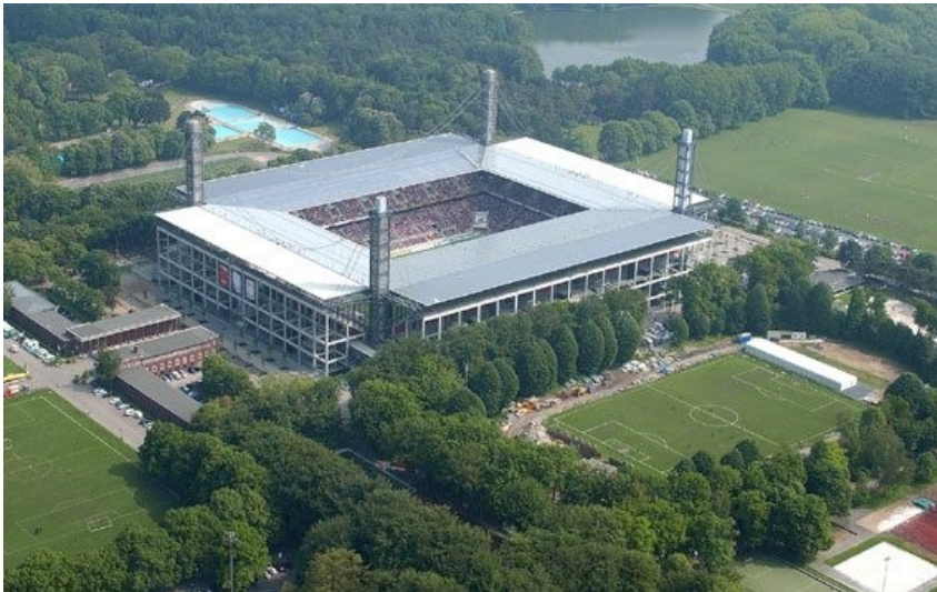
Luftbild des Sportparks Müngersdorf mit dem neuen RheinEnergie-Stadion (2012). Fotograf/Urheber: unbekannt
