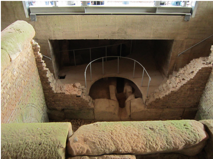
Brunnenstube "Klausbrunnen" in Mechernich-Kallmuth (2013) Fotograf/Urheber: Weber, Claus
