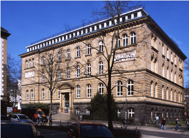
Gebäude des Instituts für Bergbau und Elektrochemie / Bergbau und Hüttenwesen der RWTH Aachen, Wüllerstraße 2 Fotograf/Urheber: Gregori, Jürgen
