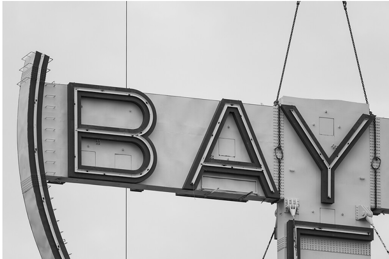
Demontage des 1963 errichteten Bayer-Kreuzes vom Dach des Werks in Krefeld-Uerdingen (22. November 2016). Fotograf/Urheber: Edgar Droste-Orlowski
