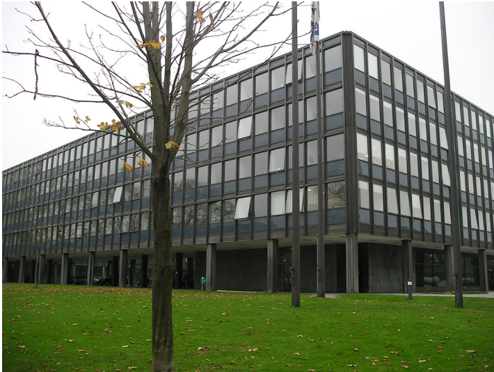
Das LVR-Landeshaus in Köln-Deutz von Osten aus gesehen (2004). Fotograf/Urheber: Hentrich, Anne
