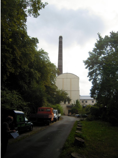
Zufahrt zur Horster Mühle in Essen und Blick auf das heutige Kraftwerksgebäude (2016) Fotograf/Urheber: Hans-Michael Altemüller
