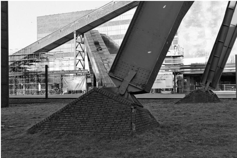
Detailaufnahme der Fundamente und der Widerlager des Fördergerüsts von Zollverein 12 (2008). Fotograf/Urheber: Seifert, Thorsten
