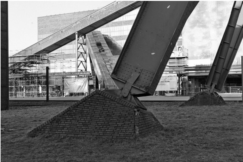
Detailaufnahme der Fundamente und der Widerlager des Fördergerüsts von Zollverein 12 (2008). Fotograf/Urheber: Seifert, Thorsten
