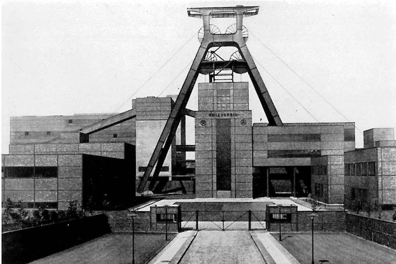
Historische Aufnahme der Anlagen von Schacht 12 der Zeche Zollverein in Essen (um 1930) Fotograf/Urheber: Hans Kania
