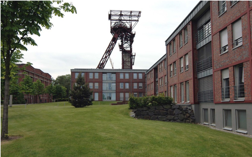
Zeche Zollverein 10 in Essen, Neubauten Fotograf/Urheber: Buschmann, Walter
