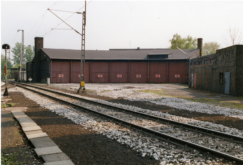
Außenansicht des Lokschuppens der Zeche Zollverein, Schächte 1-2-8 in Essen Fotograf/Urheber: Buschmann, Walter
