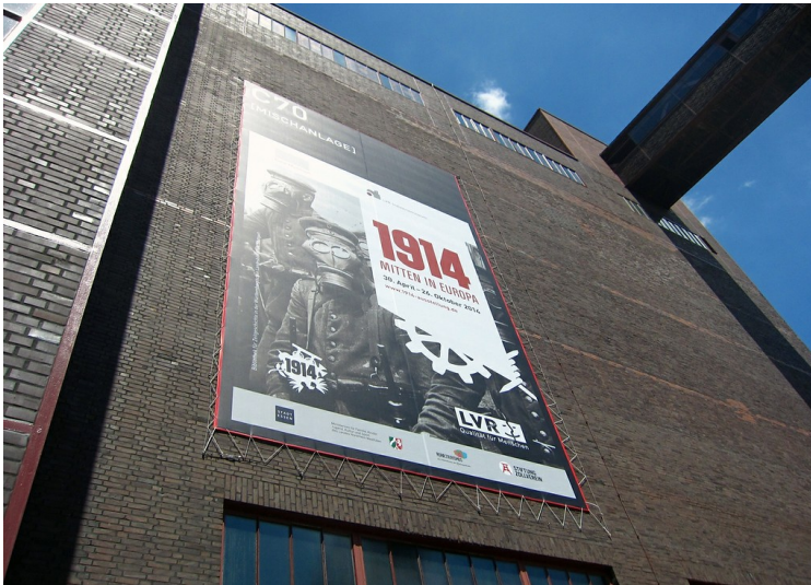
Südliche Fassade der Mischanlage der Kokerei Zollverein in Essen-Stoppenberg zum Zeitpunkt der hier stattfindenden LVR-Verbundausstellung "1914 - Mitten in Europa" (2014) Fotograf/Urheber: Franz-Josef Knöchel
