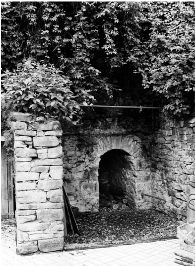
Stollenmundloch der ehemaligen Zeche Flor/Flörchen in Essen Fotograf/Urheber: Steinhoff, Manfred
