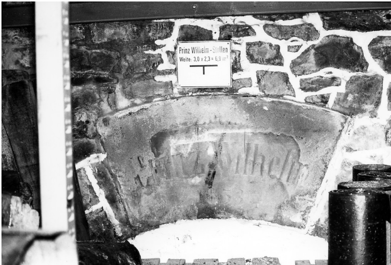
Schlussstein des Stollenmundlochs der Zeche Prinz Wilhelm in Essen-Byfang Fotograf/Urheber: Buschmann, Walter
