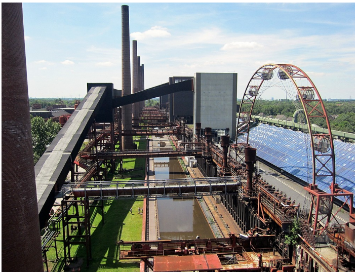
Blick über einen Teil der Anlage der Kokerei Zollverein in Essen-Stoppenberg (2014). Ganz im Hintergrund rechts der Gasometer Oberhausen. Fotograf/Urheber: Franz-Josef Knöchel
