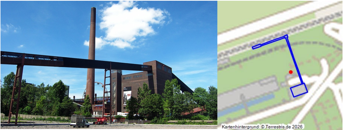
Die Mischanlage der Kokerei Zollverein in Essen-Stoppenberg (2014) Fotograf/Urheber: Franz-Josef Knöchel
