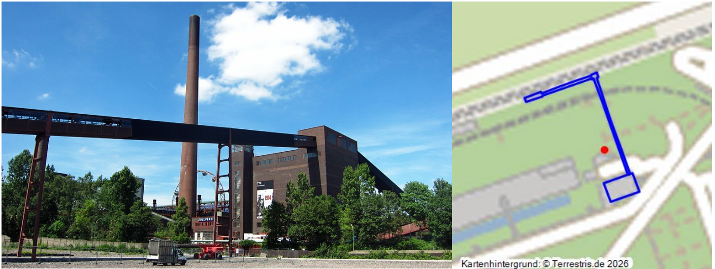
Die Mischanlage der Kokerei Zollverein in Essen-Stoppenberg (2014) Fotograf/Urheber: Franz-Josef Knöchel
