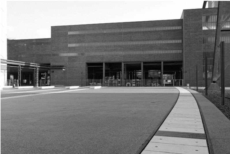
Zeche Zollverein 12 in Essen; Blick in den Bereich zwischen den nördlichen und den südlichen Teil des ringförmig ausgebildeten Wagenumlaufes. 2008 Fotograf/Urheber: Seifert, Thorsten
