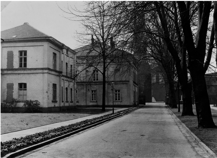
Direktorenvilla und alte Verwaltung der Zeche Zollverein, Schächte 1-2-8 in Essen
