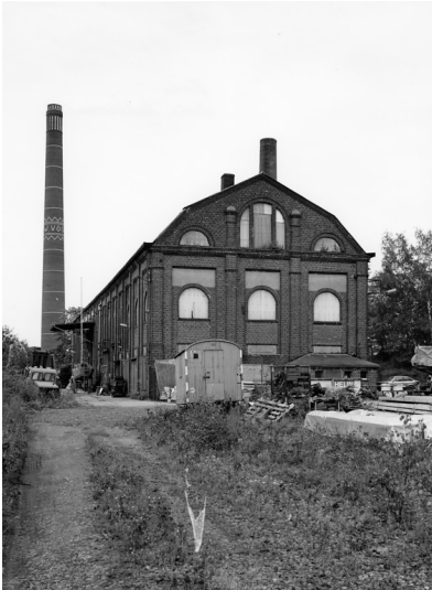
Betriebsgebäude der Zeche Wohlverwahrt in Essen-Horst Fotograf/Urheber: Steinhoff, Manfred
