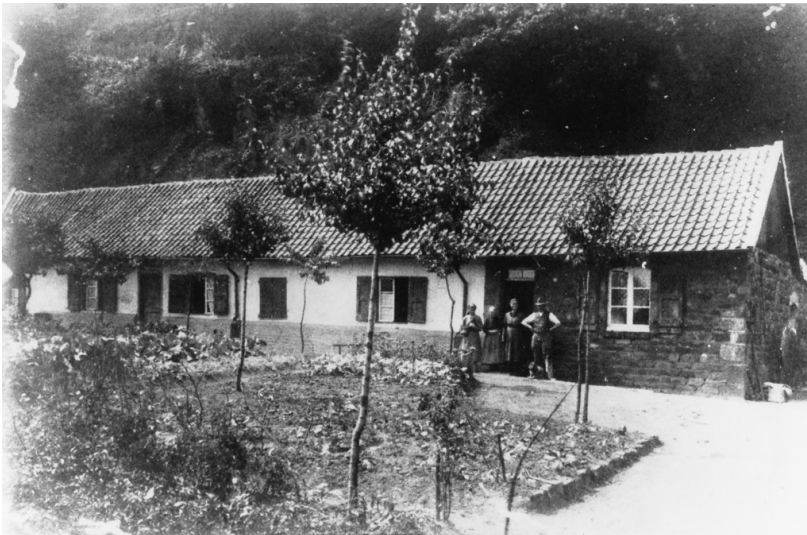
Büro- und Werkstattgebäude der ehemaligen Zeche Flor/Flörchen Fotograf/Urheber: Archiv LVR-ADR
