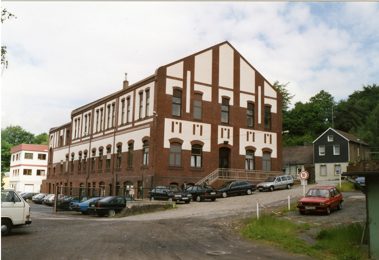
Verwaltungs- und Kauengebäude der Zeche Viktoria in Essen Fotograf/Urheber: Buschmann, Walter
