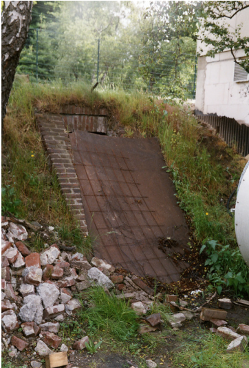
Stollenmundloch Himmelscroner Erbstollen der Zeche Viktoria in Essen Fotograf/Urheber: Buschmann, Walter
