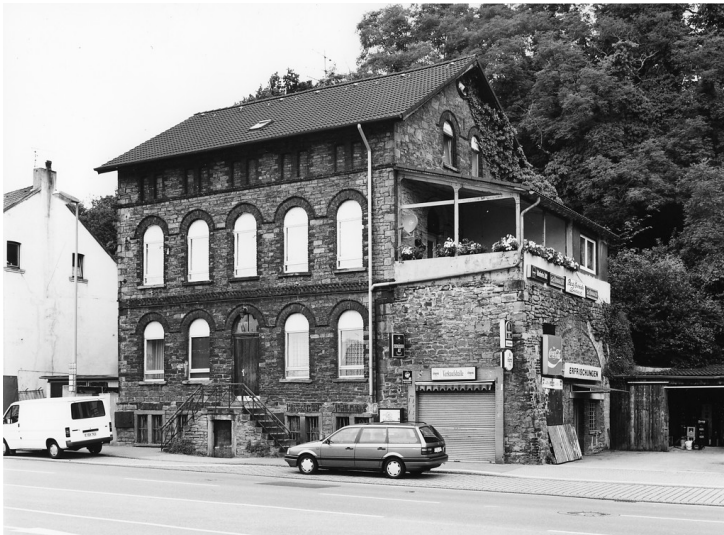
Zeche Deimelsberg, Verwaltungsgebäude in Steele Fotograf/Urheber: Steinhoff, Manfred
