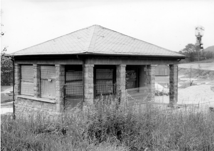
Pförtnerhaus der Zeche Carl Funke in Essen Fotograf/Urheber: Buschmann, Walter
