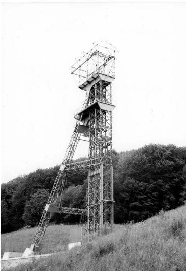
Fördergerüst der Zeche Carl Funke in Essen Fotograf/Urheber: Buschmann, Walter
