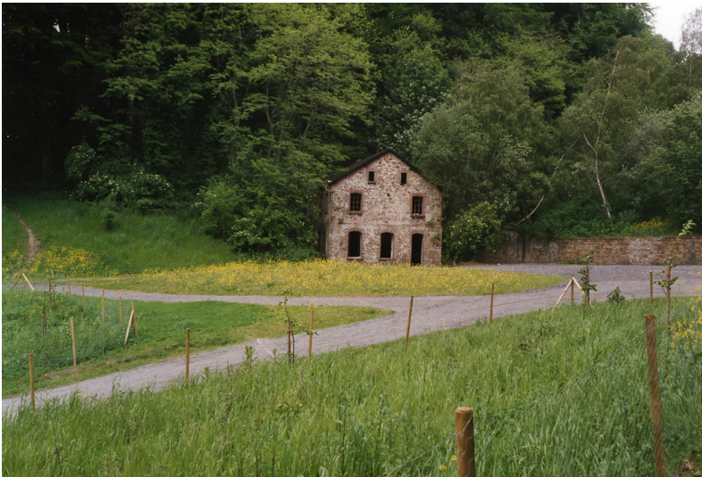
Maschinenhaus der Zeche Carl Funke in Essen Fotograf/Urheber: Buschmann, Walter
