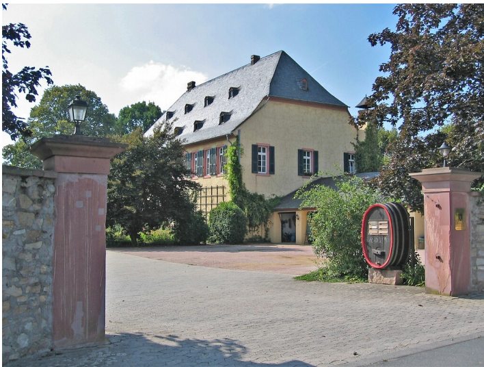
Draiser Hof in Eltville (2005) Fotograf/Urheber: Dagmar Söder
