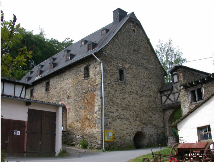
Zehntscheune des Klosters Gronau Fotograf/Urheber: Büttner, Dr. Thomas
