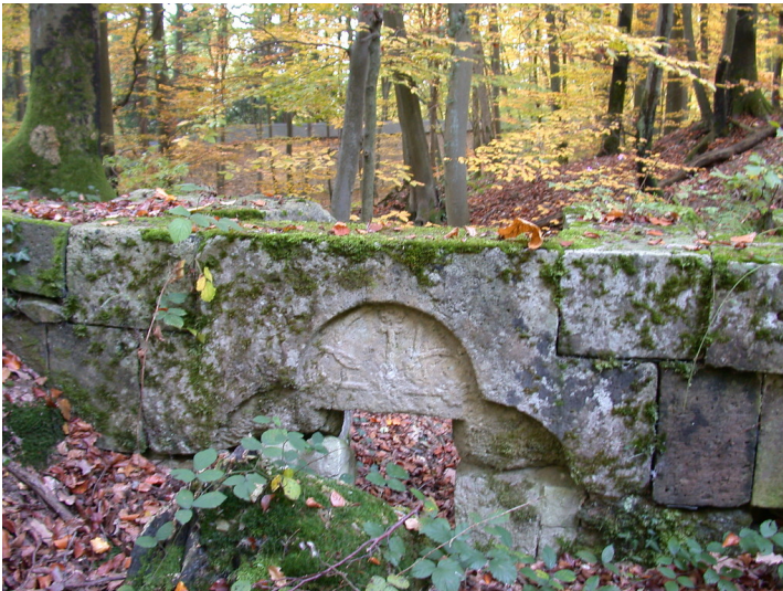
Stauwehr, Eberbach Fotograf/Urheber: Büttner, Thomas
