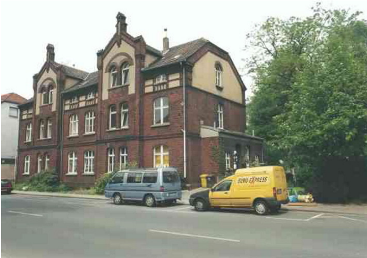
Gebäude in der Ückendorferstraße 71a-73a, Siedlung Kolonie III in Essen-Katernberg (2010) Fotograf/Urheber: UDB Essen
