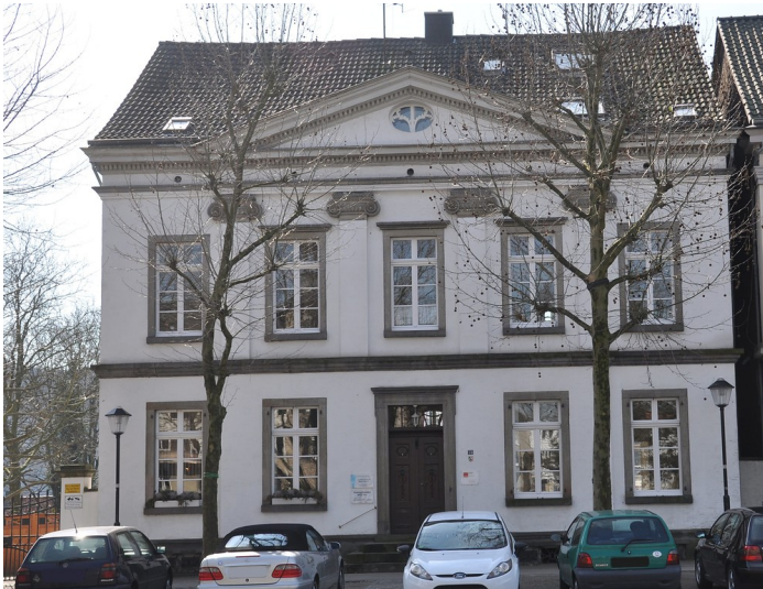
Wohnhaus Hauptstraße 75 in Essen Kettwig Fotograf/Urheber: Buchholz, Karl-Heinz
