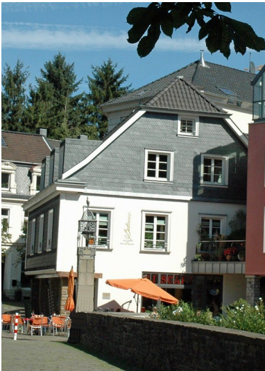
Kellergewölbe im Haus Am Mühlengraben 1 (Stadt Essen Baudenkmal Nummer 927), Essen Kettwig Fotograf/Urheber: Karl-Heinz Buchholz
